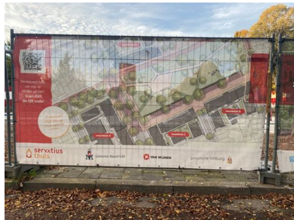
Figuur 3.1.27: Oktober 2022. Een plattegrond met ook het 4e woonblok wordt bij het laatst gesloopte terrein opgehangen.
