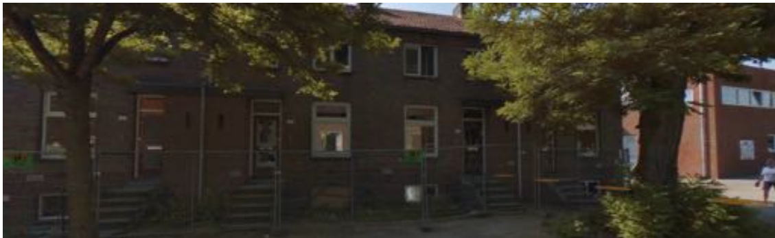
Figuur 3.4.3: In 2013 staan de bouwhekken voor de sloop later dit jaar om de woningen (Cyclorama, 2013)
