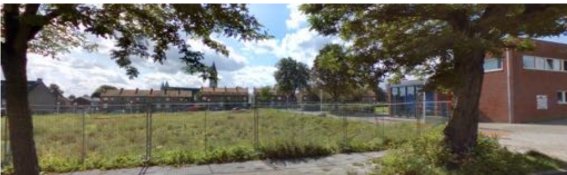
Figuur 3.4.4: In 2014 zijn alle woningen gesloopt en is doorkijk mogelijk (Cyclorama, 2012)
