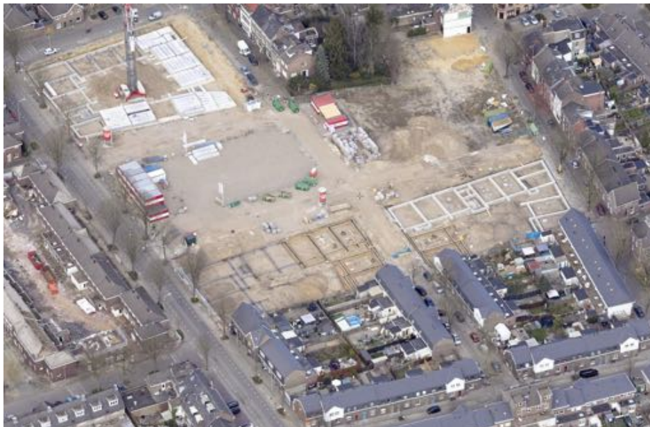
Figuur 3.1.14: obliek-foto van het totale gebied van het buurtpark en omgeving, na de sloop in 2022 (Slagboom en Peeters, 2022).
