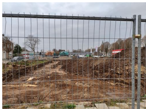
Figuur 3.1.22: December 2021. De bouwhekken worden teruggeplaatst en er wordt gestart met afgraven voor de gebouw-funderingen.
