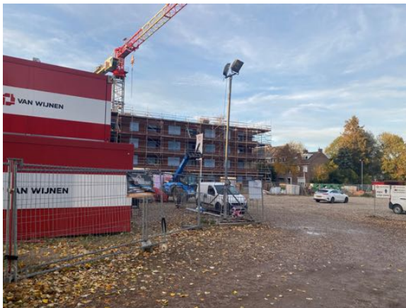
Figuur 3.1.26: Oktober 2022. De meeste gebouwen zijn gebouwd tot aan hun uiteindelijke hoogte.
