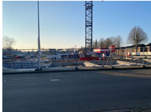
Figuur 3.1.25: Maart 2022. De gebouw-funderingen worden gelegd.
