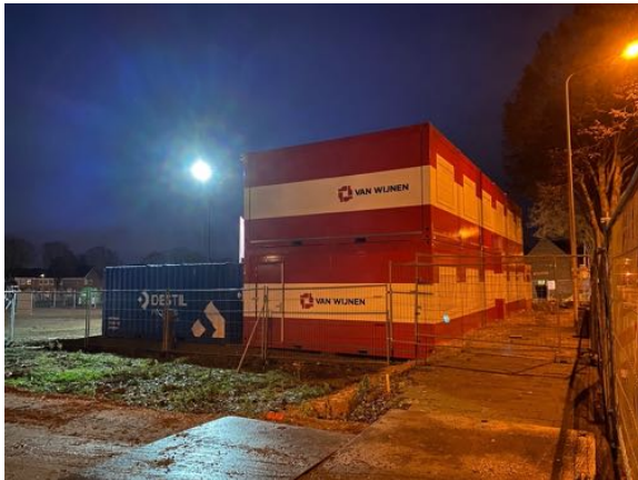
Figuur 3.1.24: Januari 2022. De bouwketen zijn geplaatst.
